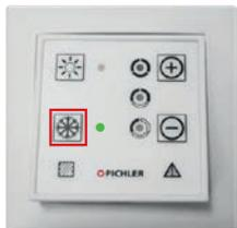
**Winterbetrieb** & untere Leuchtdiode leuchtet grün. Erwärmt eingebrachte Außenluft über die Wärmerückgewinnung und zusätzlich über das automatische Nachheizregister, falls installiert (Der geräteintegrierte Bypass ist deaktiviert).
